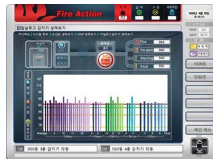
아날로그감지기 상태 표시
